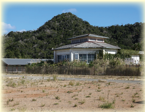
大和城バンガロー-建物地東側の既存建物
