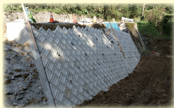
大津川千間線の改良状況
