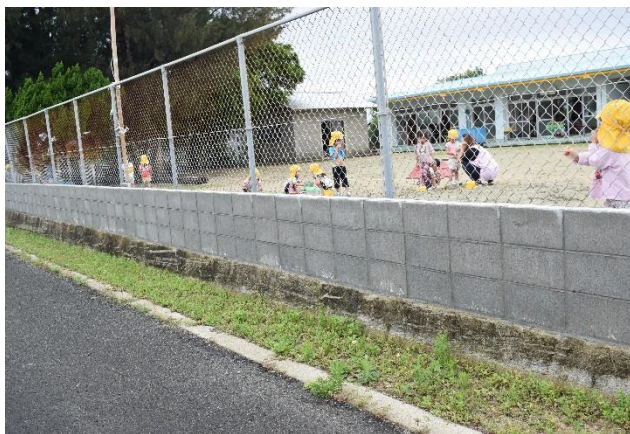
北部保育所外壁修繕
