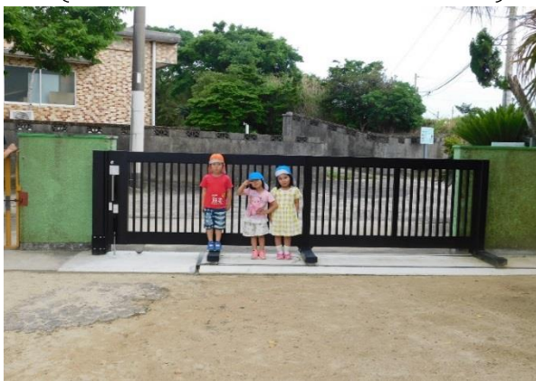
南部保育所門扉取替修繕
