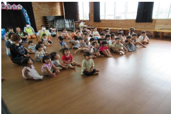
天城保育所ホール床張り替え
