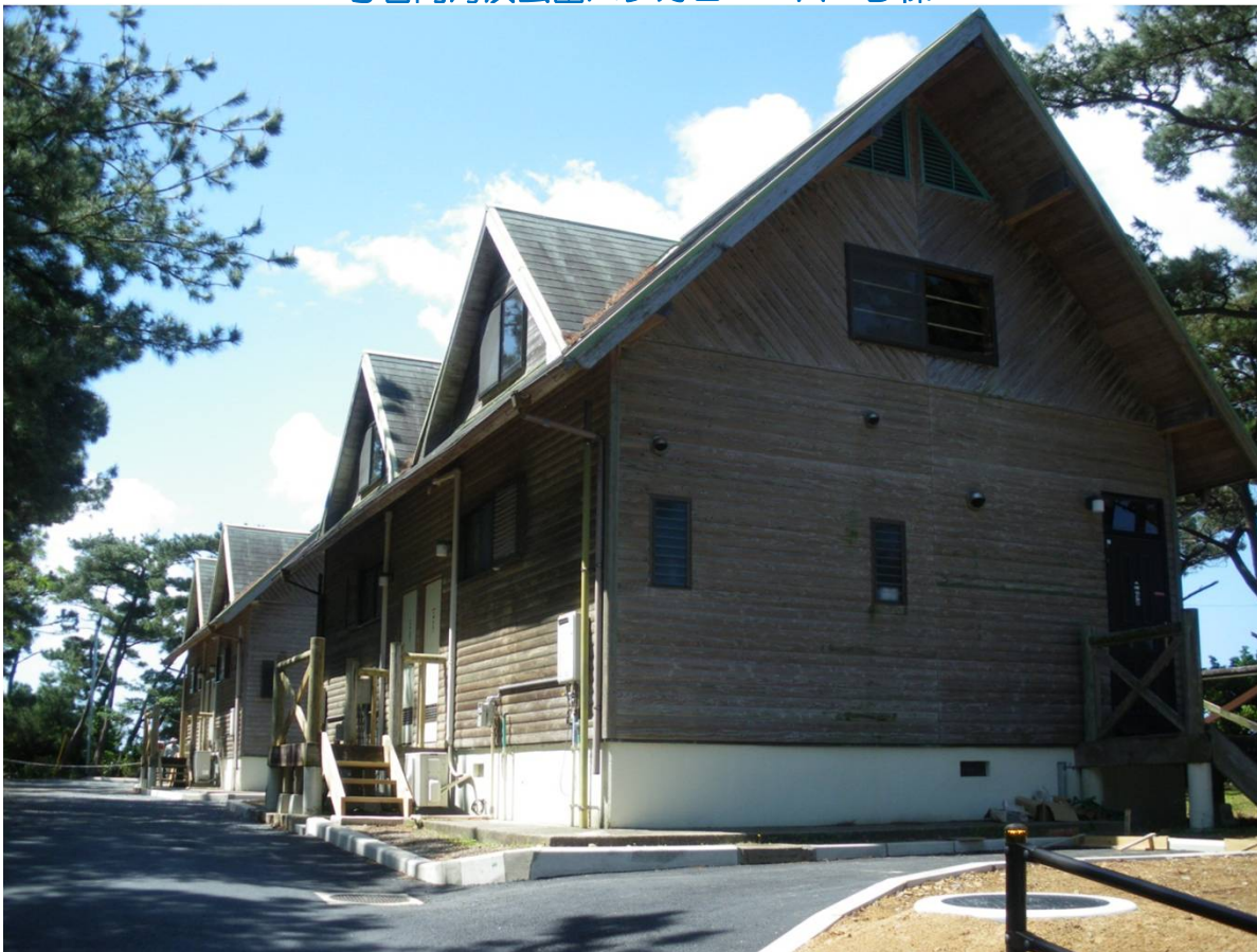
手前からA棟：やどかり，B棟：はまゆう，C棟：あだん，D棟：はまひるがお
