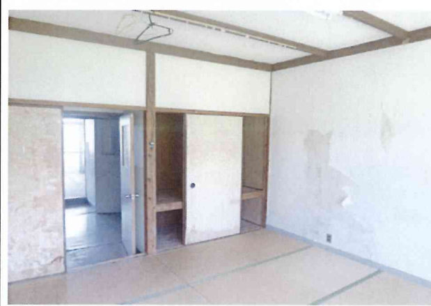
修繕前・宿泊室
