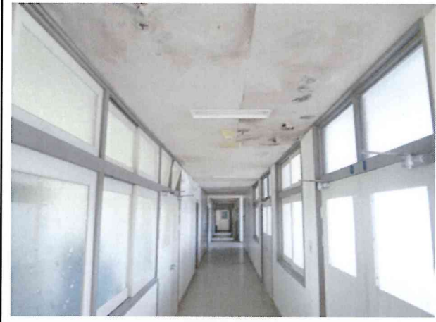
修繕前・廊下
