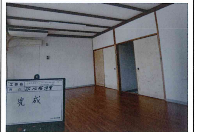
修繕後・宿泊室
