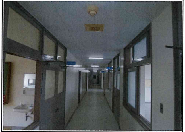
修繕後・廊下
