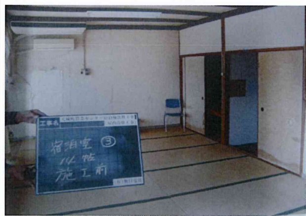
修繕前・宿泊室
