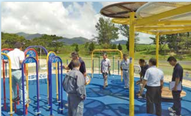
▲ わんぱく広場遊具設置工事（総合運動公園内）
