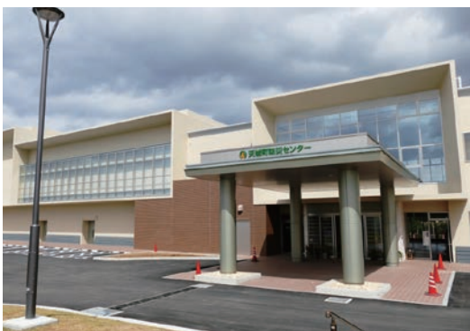
防災センター
