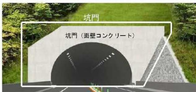
図-8.6.2 点検対象箇所(トンネル坑口部)
