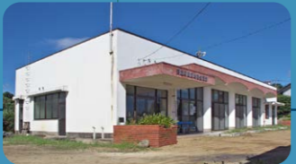
避難所 岡前生活館
